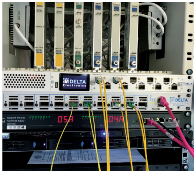
Abbildung 1: Headend mit XFP- und SFP-Chassis von DCT Delta
